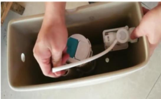
Führen Sie den Überlaufschlauch des Einlaufventils in den Überlauf der Innengarnitur
