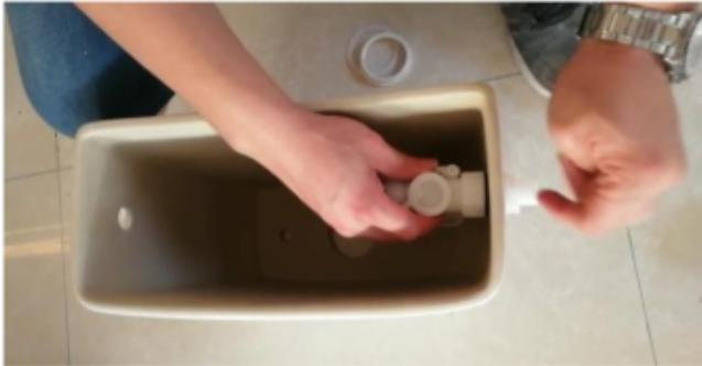
Setzen Sie das Einlaufventil in die dafür vorgesehene Öffnung und befestigen Sie diese mit der Überwurfmutter. Bitte darauf Achten das die Dichtung (Schwarz) innen liegt.
