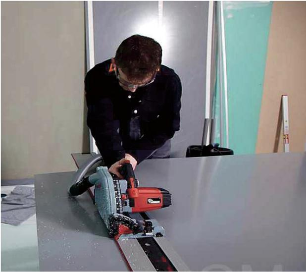
**3.2** Bei langen Schnitten sollte eine Führungsschiene verwendet werden, um eine exakte Bearbeitung gewährleisten zu können. Vorsicht beim Sägeschnitt - Eingang und Ausgang (Gefahr von Ausbruch). Auf richtiges Sägeblatt achten (S. 3). Die Schutzfolie verbleibt während der gesamten Säge- und Bohrvorgänge auf der Design - Platte.
