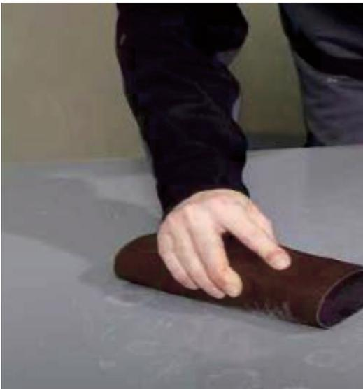
**3.7** Drehen Sie nun die Platte, um die Rückseite mit dem beiliegenden 240er Schleifpapier ganzflächig anzurauen. Dazu müssen Sie zuvor die Schutzfolie abziehen, bevor Sie mit dem Anrauen beginnen. Der dabei entstehende Staub muss entfernt werden.
