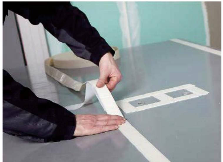
**3.8** Verwenden Sie nun das Spiegelklebeband (40 mm breit, 2 mm dick erhältlich in unserem Montage Kit) und bringen dies unter Berücksichtigung eines Randabstands von 20 mm zur Außenkante der Platte auf. Große Bohrungen oder Ausschnitte (für Toiletten, Waschtisch, Spülkasten...) sollten ausreichend mit Spiegelklebeband hinterlegt werden, damit bei späteren Belastungen ein Gegenlager vorhanden ist. Klebebahnen im Abstand von ca. 400 mm anordnen.
