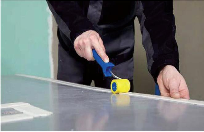
**3.9** Das Spiegelklebeband muss nach dem Aufbringen noch einmal fest angedrückt werden. Dies funktioniert am besten mit einem Tapetenroller.
