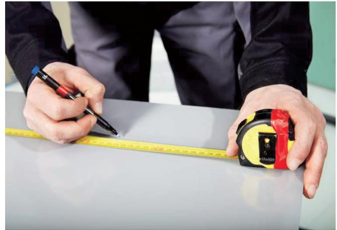
**2.3** Übertragen Sie nun die fertigen Zuschnittmaße mittels Folienstift auf die Frontseite (Rückseite ist durch Aufkleber gekennzeichnet) der Designplatte. Die Schutzfolie bitte nicht entfernen.
