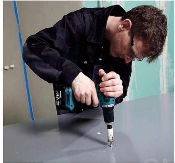
**3.4** Beim Bohren mit der Lochsäge den Bohrvorgang mehrfach unterbrechen, um Späne abzuführen. Damit wird ein Verschweißen der Späne mit der Platte verhindert. Es werden niedrige bis mittlere Schnittgeschwindigkeiten empfohlen.
