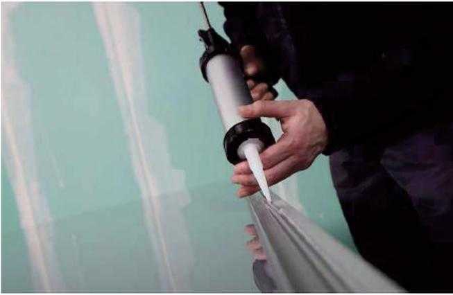
**3.13** Die Profilflanken mit einer durchgehenden dünnen Linie essigsäurefrei vernetzendem Naturstein-Silikon versehen und Profil aufkleben.
