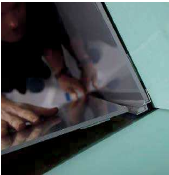
3.15 Beim Setzen der zweiten Platte wieder aus der Ecke beginnend anlegen und andrücken.
