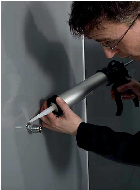
3.17 Durchführungen mit essigsäurefrei vernetzendem Naturstein-Silikon abdichten.
