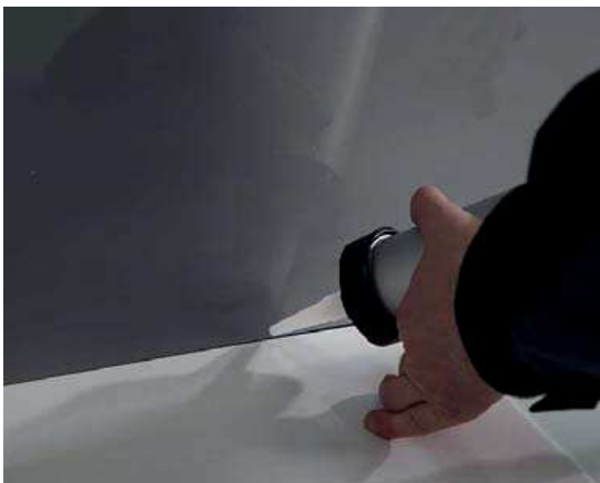
3.19 Bodenbereich mit essigsäurefrei vernetzendem Naturstein-Silikon abdichten. Das Silikon 24h aushärten lassen.
