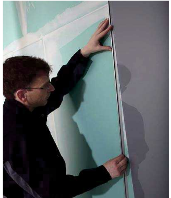
3.14 Das Abschlussprofil (ebenfalls mit einer dünnen Linie auf der Flanke silikonieren) kann vor oder unmittelbar nach dem Anbringen der Platte aufgesetzt werden.
